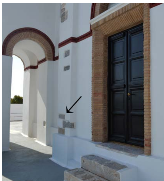
Fig. 4: Ἱερός Ναός Ἀγ. Ἀναργύρων: parete esterna meridionale, la freccia indica la pietra iscritta
