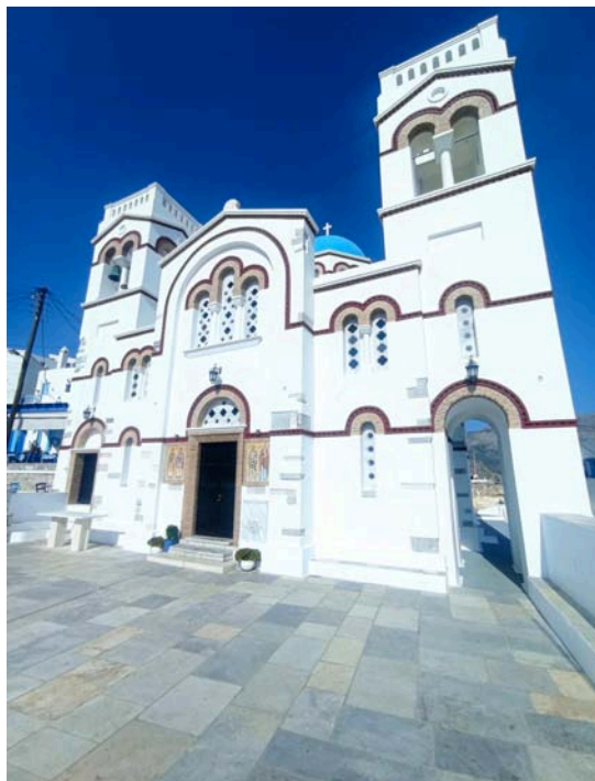
Fig. 3: Ἱερός Ναός Ἀγ. Ἀναργύρων: fronte
